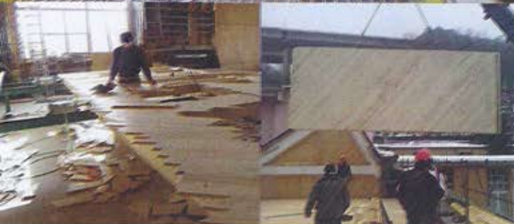
IN ALTO, POSA DELLE TUBAZIONI DEL RISCALDAMENTO A PAVIMENTO. QUI SOPRA, LA REALIZZAZIONE IN OFFICINA DI UNA PARETE ESTERNA E, A DESTRA, IL SUO MONTAGGIO: IL FISSAGGIO IN DIAGONALE DELLE TAVOLE GARANTISCE UNA MAGGIORE STABILITÀ. L'EDIFICIO DI ROSSIGLIONE È CLASSIFICATO IN CLASSE A CON CERTIFICAZIONE ENERGETICA DELLA REGIONE LIGURIA.
